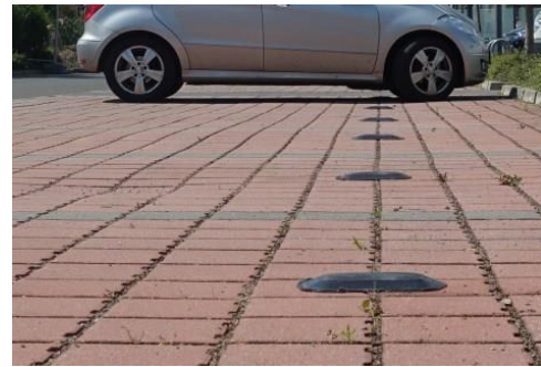
Abbildung 35: Beispiel für Bodensensoren zum Detektieren der Belegung
